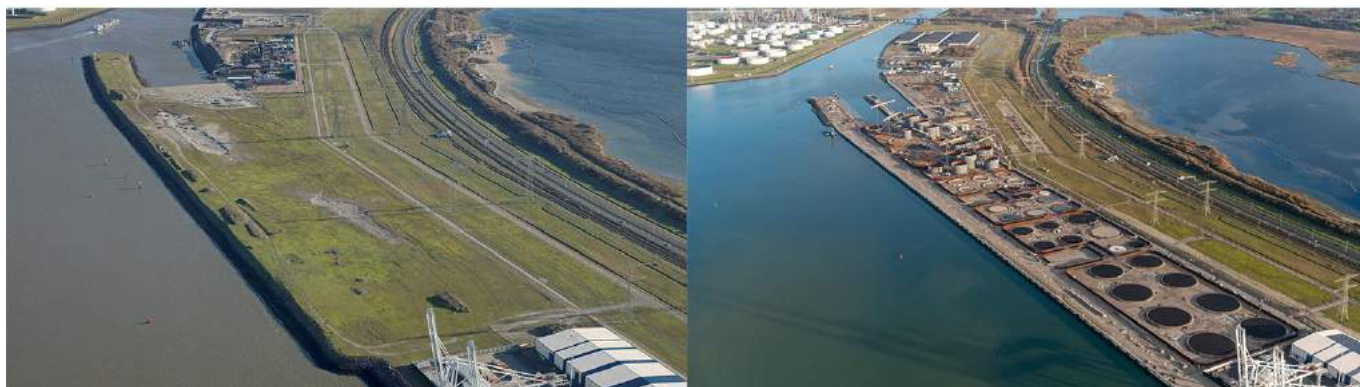
Situatie bij aanvang werkzaamheden (links) en na oplevering (rechts) van de kademuren en steiger HES Hartel Tank Terminal.
