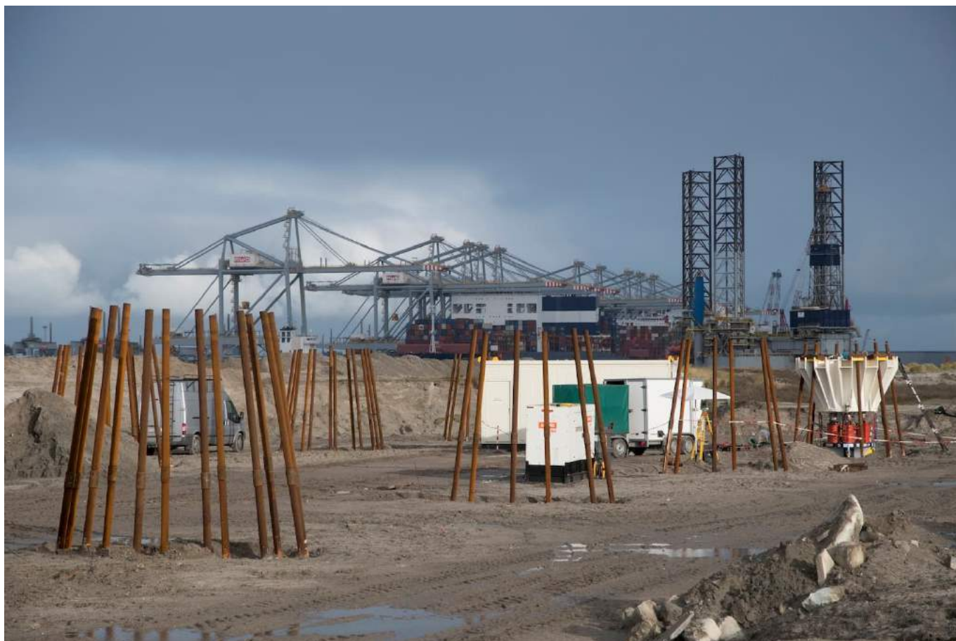
Fundatiepalenproef bij de Prinses Amaliahaven op de Maasvlakte 2.
