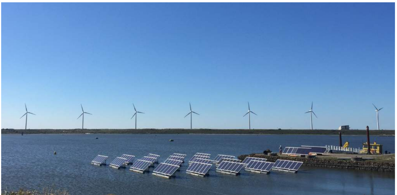
Het drijvende zonnepark in de Slufter.
